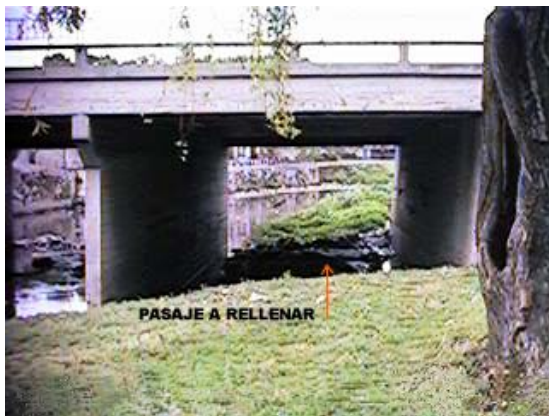
PUENTE DE LA AVENIDA AGRACIADA
