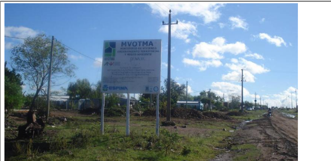
Imagen: Barrio Las Láminas- Comienzo de intervención del MVOTMA. DINAGUA, 2012
